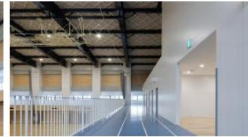
さて体育館の方では斜め格子母屋工法を採用頂き、小梁が少なく見え目にとってもスッキリと仕上がっています。黒に塗られた大梁の色使いが炭鉱の町としての力強さを感じさせてくれます。
